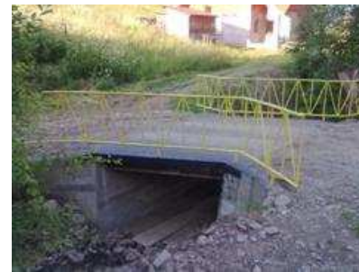
Obr. 2: Zrekonštruovaný mostík na ulici Potok
